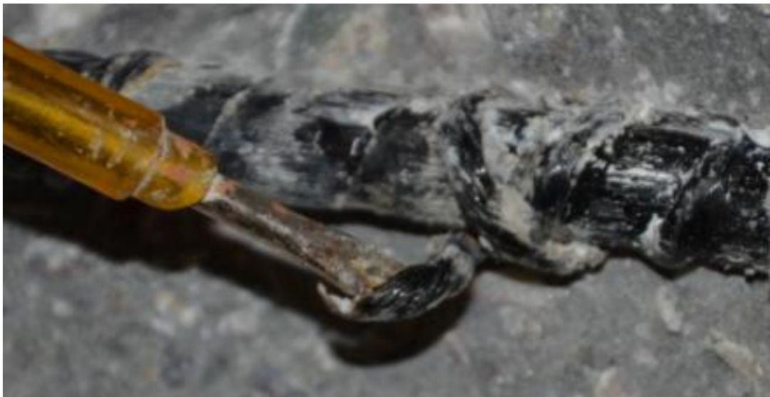
Resim 4.9. Kesme çatlağı oluşan kirişte bazalt lifli donatının yüzey görünümü (3. Kiriş)
