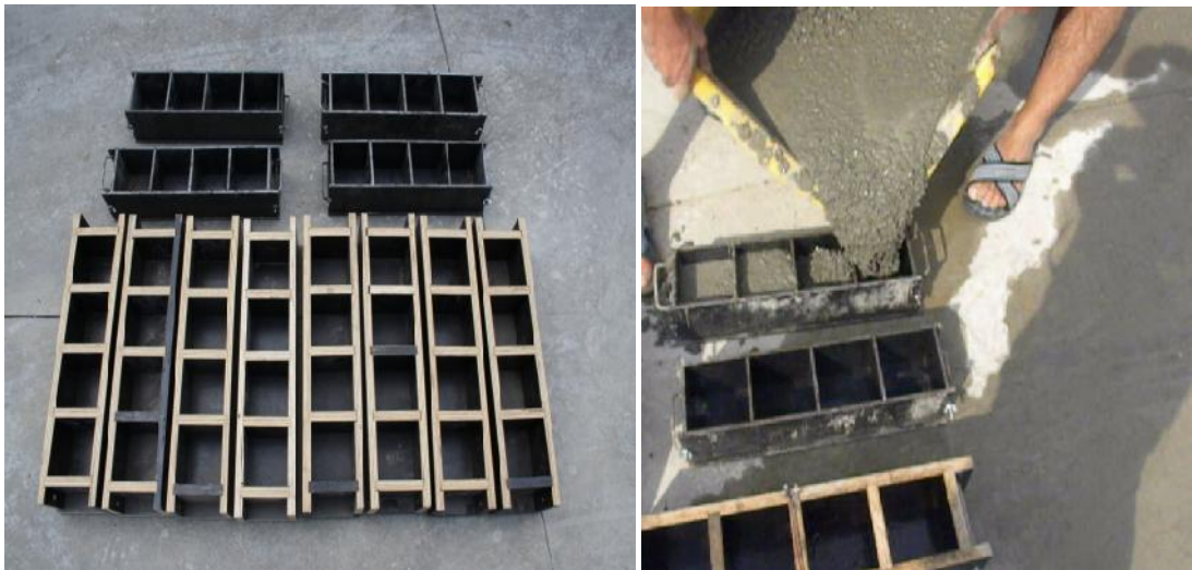
Resim 3.8. Kullanılan kalıplar-kalıplara betonların yerleştirilmesi
