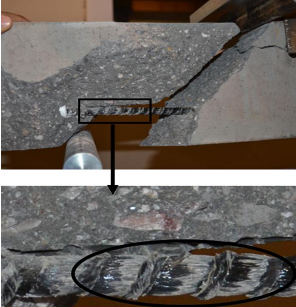
Resim 4.7. Kesme çatlağı oluşan kirişte bazalt lifli donatının yüzey görünümü (1. Kiriş)
