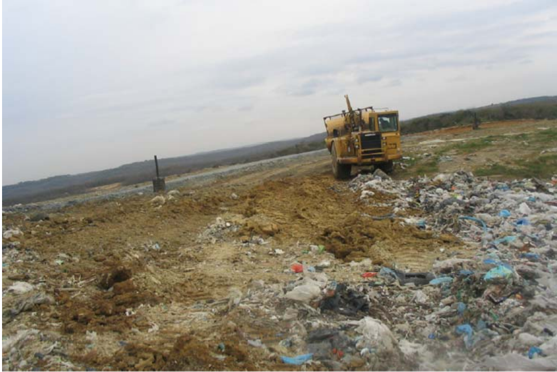
Resim 4.1. Yıpranmış örtü tabakasının ilave örtü ile tamamlanması [16].
