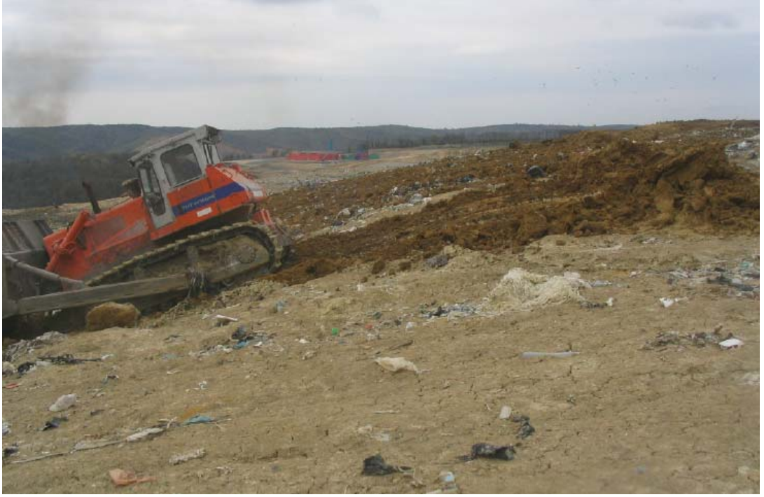
Resim 4.2. Yıpranmış örtü tabakasının ilave örtü ile tamamlanması [16]
