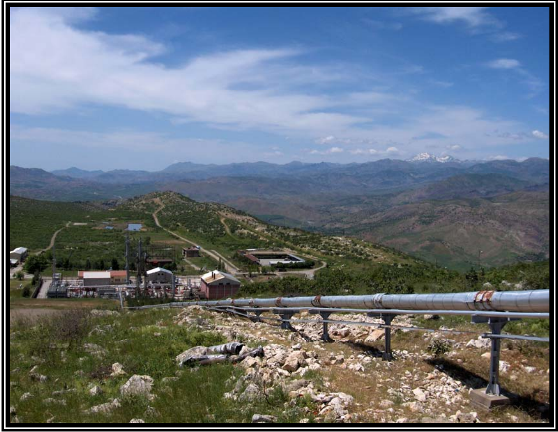
Resim 7. 1. Baykan / Dodan karbondioksit tesisleri
