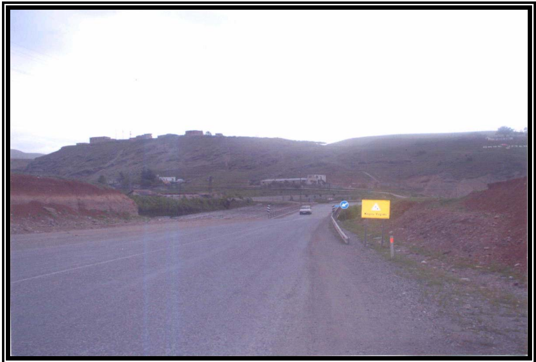
Resim 8. 2. Bölünmüş yol çalışmaları
