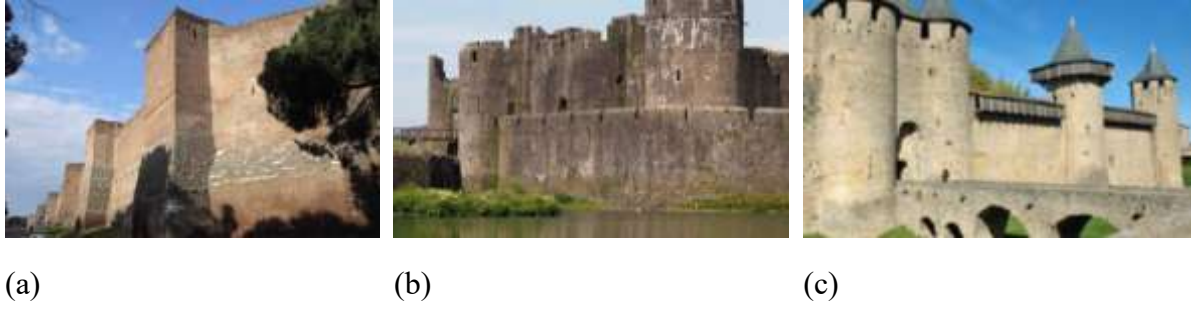
Resim 1.1. Eski çağlarda savunma duvarları (URL-3,20,21)
