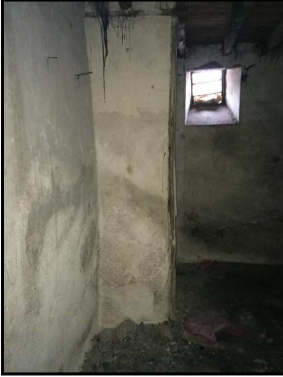
Resim 4.12. Z02 mekanı dv1-dv2 duvarı
