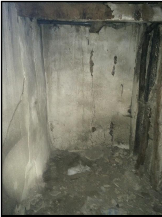
Resim 4.16. Z02 mekanı dv6- dv7 duvarı
