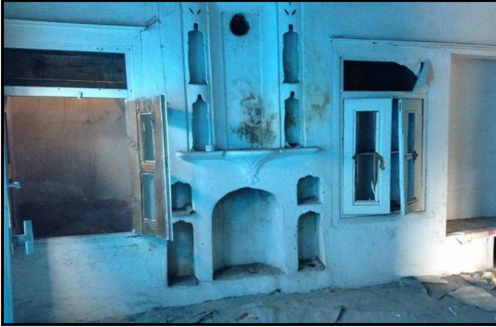
Resim 4.74. 102 mekan dv3 duvarı
