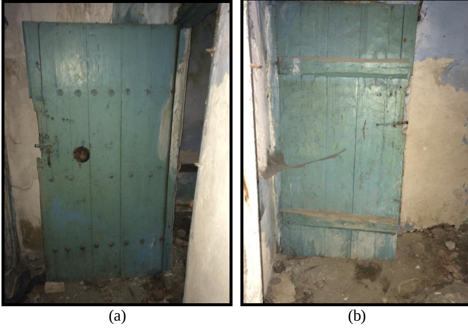
Resim 4.146. K.Z04.1 nolu kapı (a) Z04 nolu oda kapısı (b) Z04 kapısı ahşap kuşaklar
