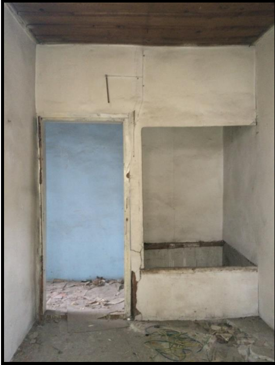
Resim 4.91. 106 mekan dv1 duvarı
