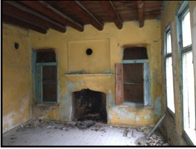
Resim 6.5. Z10 nolu mekan dolapları
