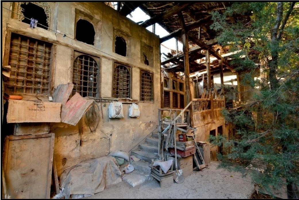
Resim 5.42. 1 nolu konak cephesi
