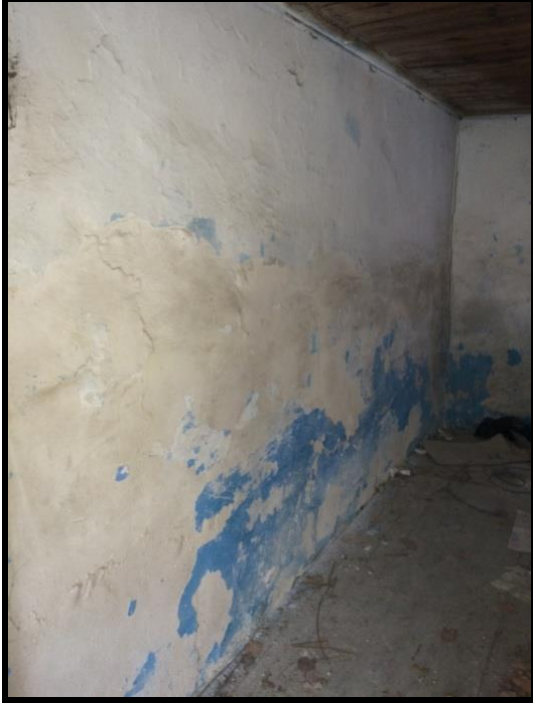
Resim 4.29. Z05 hol dv1 duvarı
