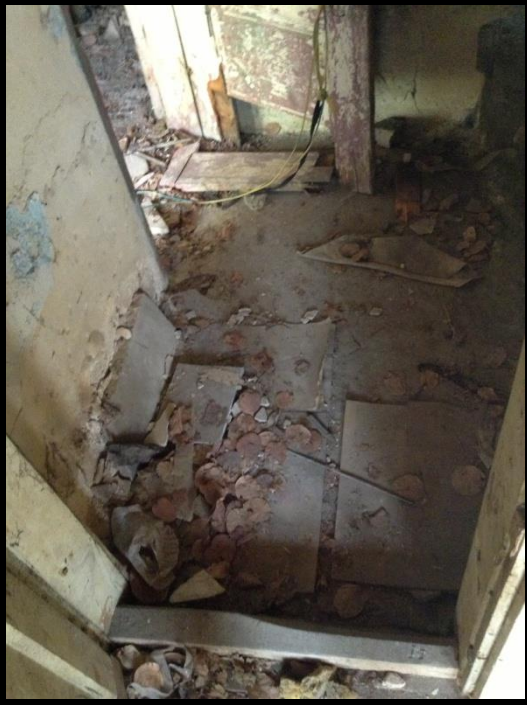
Resim 4.46. Z08 hol döşemesi
