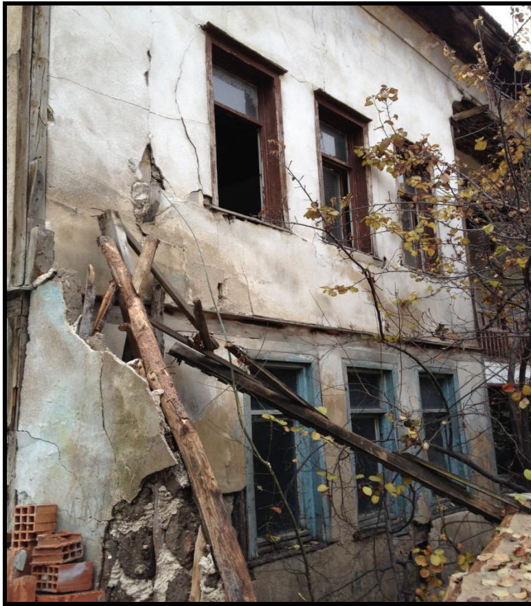
Resim 6.1. Saticı konağı bahçe duvarı
