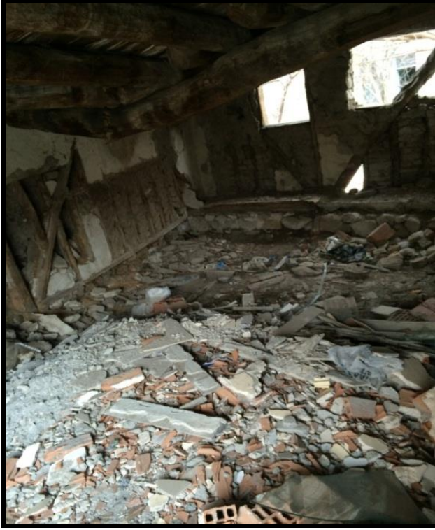
Resim 4.124. Ahır DV3 duvarı
