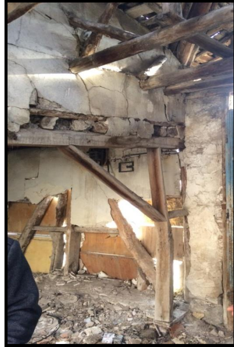
Resim 4.128. Tandır önündeki mekan tavanı Resim 4.129. Payanda detayı
