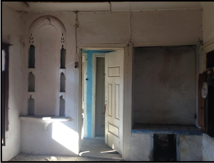
Resim 4.81. 104 mekan dv1 duvarı
