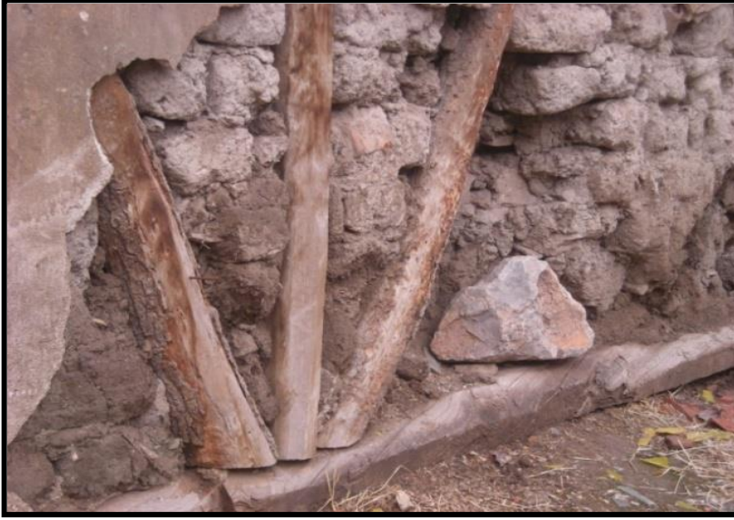
Resim 4.116. Konak duvarları ve yapım sistemi
