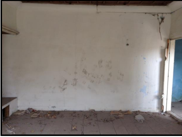
Resim 4.70. 101 mekan dv4 duvarı
