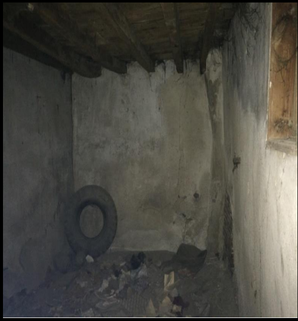
Resim 4.36. Z06 mekan dv3-dv4 duvarı
