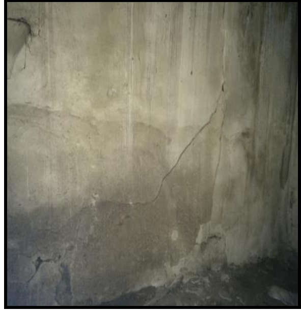
Resim 4.15. Z02 mekanı dv5 duvarı
