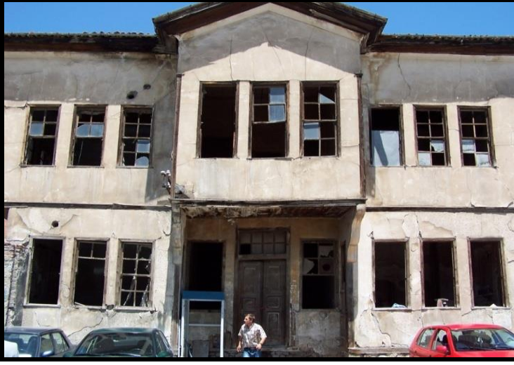
Resim 2.18. Çorum İli Eski Karakol Binası
