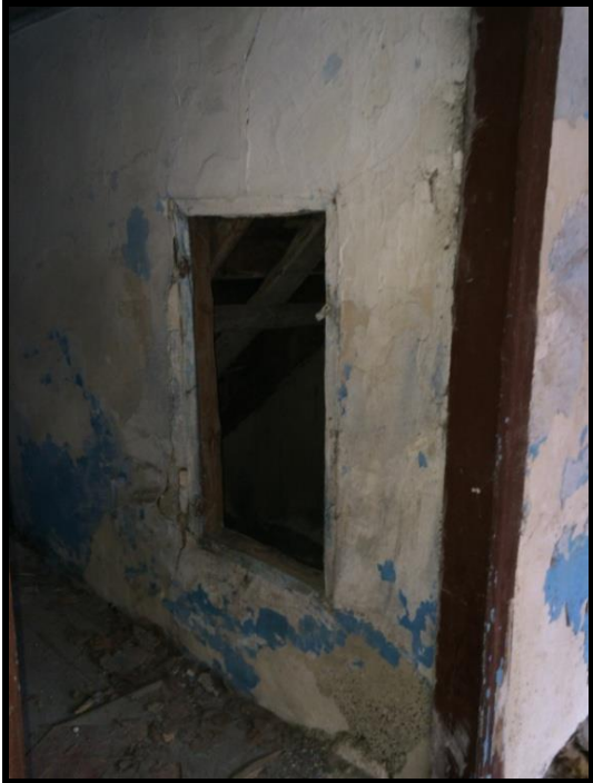
Resim 4.31. Z05 hol dv3 duvarı
