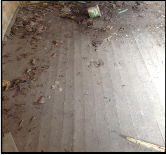
Resim 4.58. Z10 mekan döşemesi
