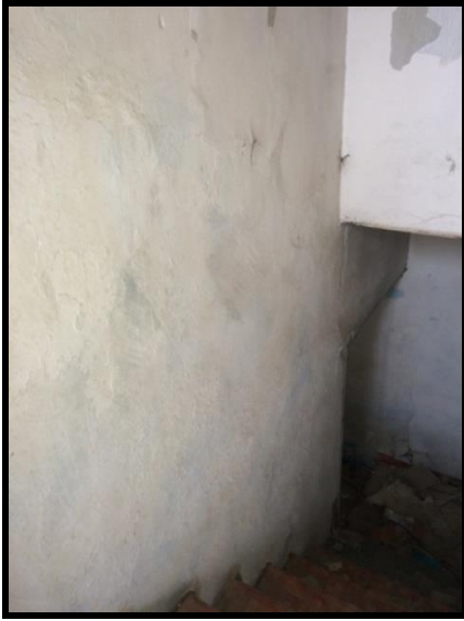
Resim 4.87. 105 hol dv1 duvarı
