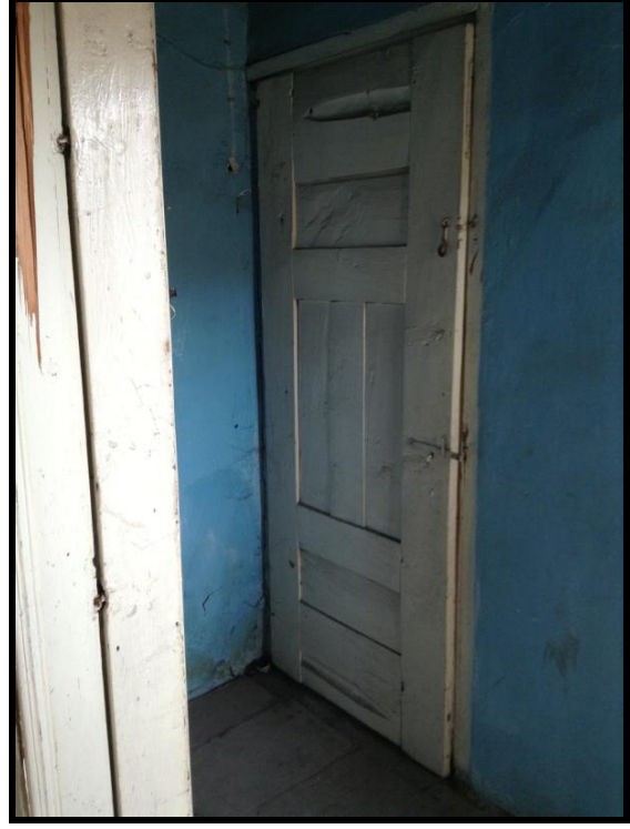
Resim 4.78. 103 hol dv3 duvarı
