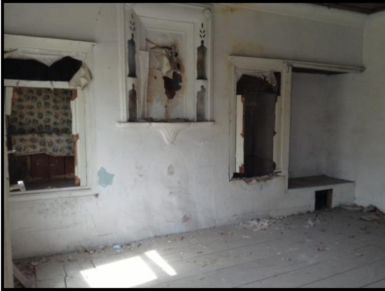
Resim 4.69. 101 mekan dv3 duvarı
