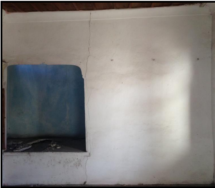
Resim 4.83. 104 mekan DV3 duvarı
