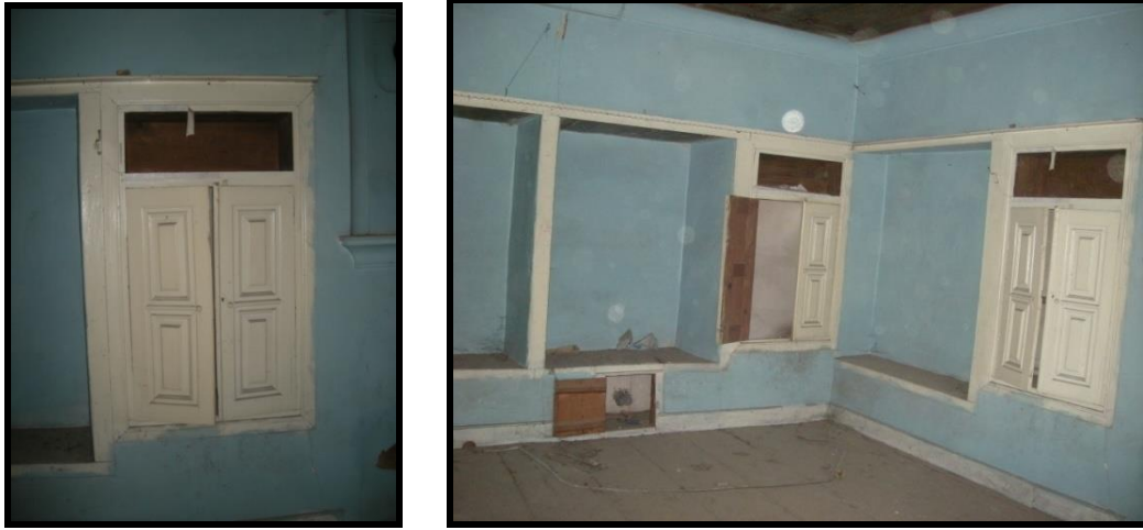
Resim 6.10. 108 mekan dolap kapakları
