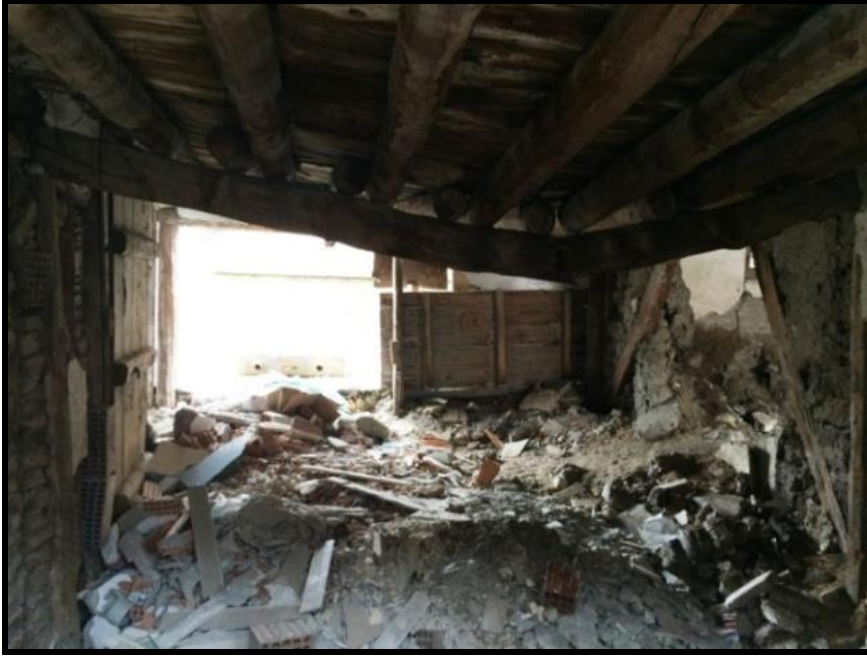
Resim 4.122. Ahır dv1 duvarı
