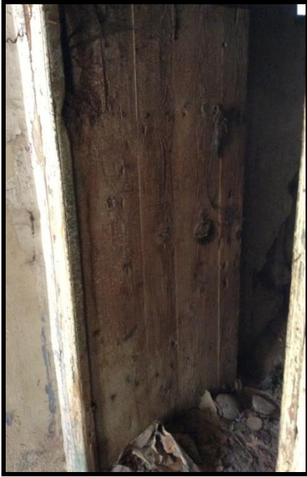
Resim 4.147. K.Z06.1 nolu kapı
