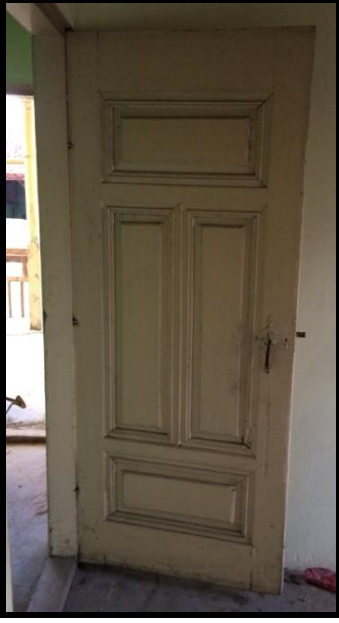
Resim 5.19. 6 nolu konak oda kapısı
