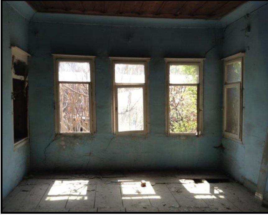
Resim 4.103. 108 mekan dv3 duvarı
