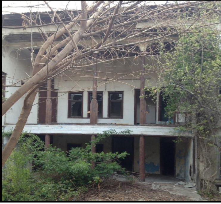
Resim 4.118. Ahşap taşıyıcı kolonlar
