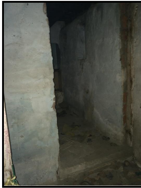
Resim 4.44. Z08 hol DV2 duvarı
