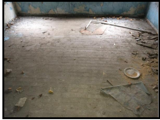
Resim 4.11. Z01 mekan döşemesi
