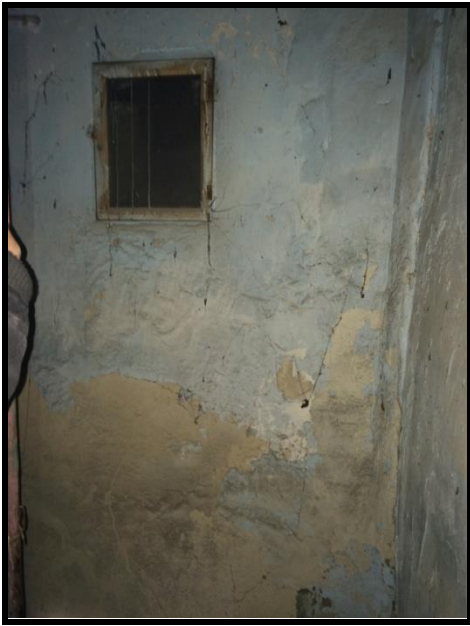
Resim 4.43. Z08 hol DV1 duvarı
