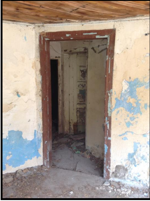
Resim 4.40. Z07 hol DV3 duvarı
