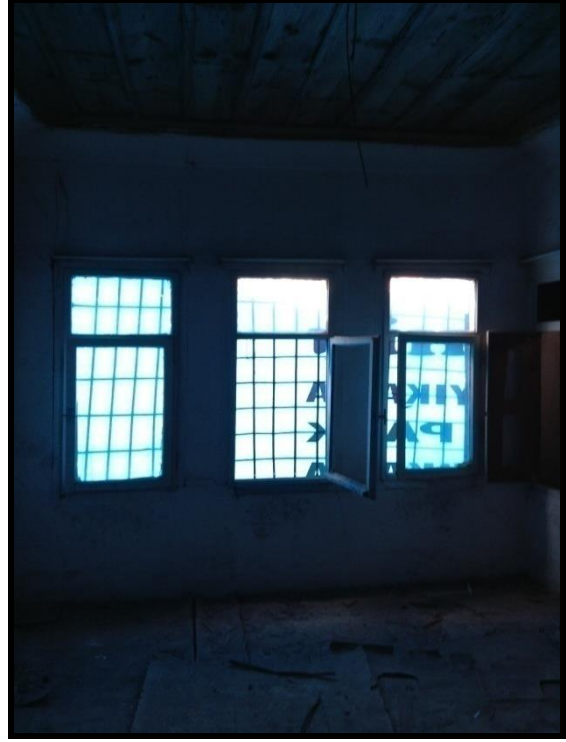
Resim 4.73. 102 mekan dv2 duvarı
