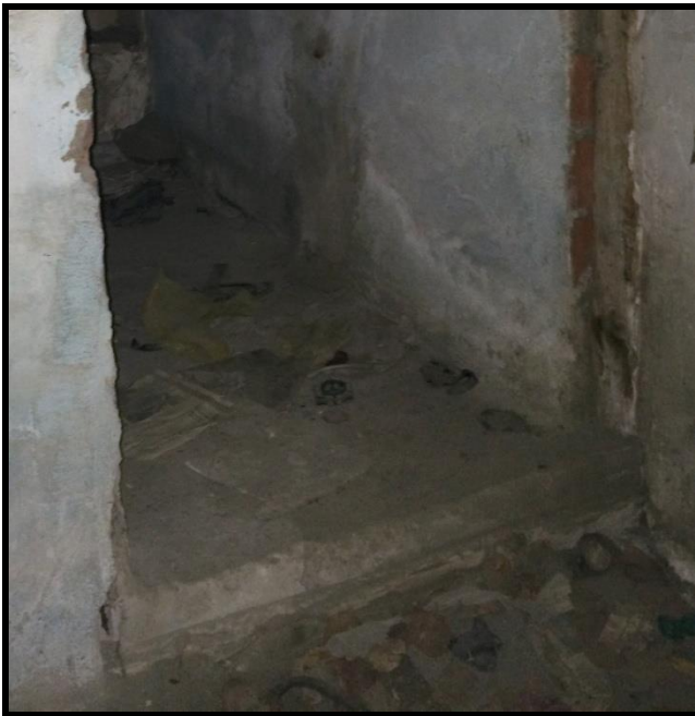
Resim 4.52. Z09 mekan döşemesi
