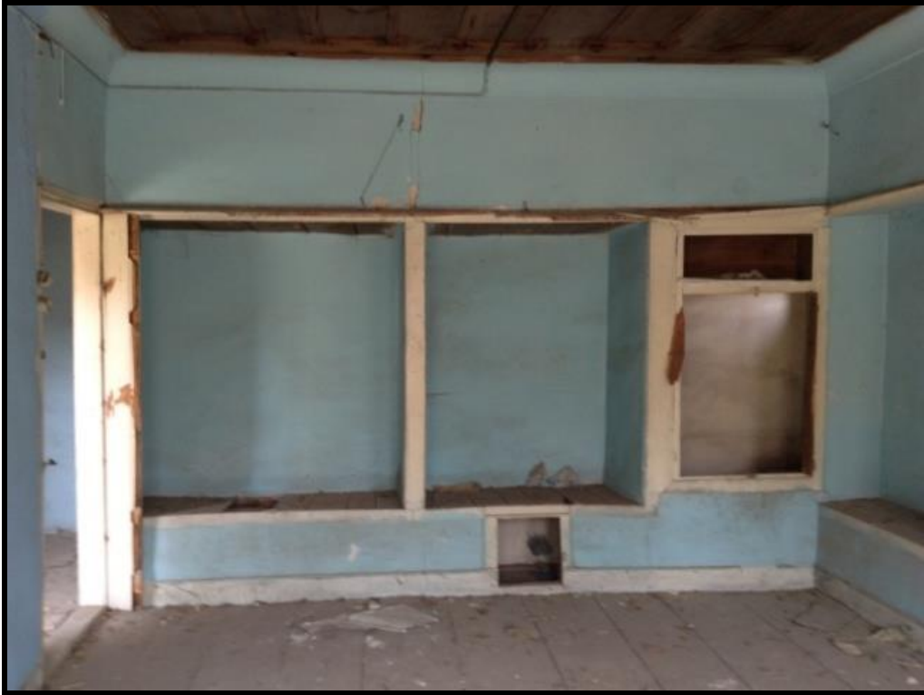
Resim 4.101. 108 mekan dv1 duvarı
