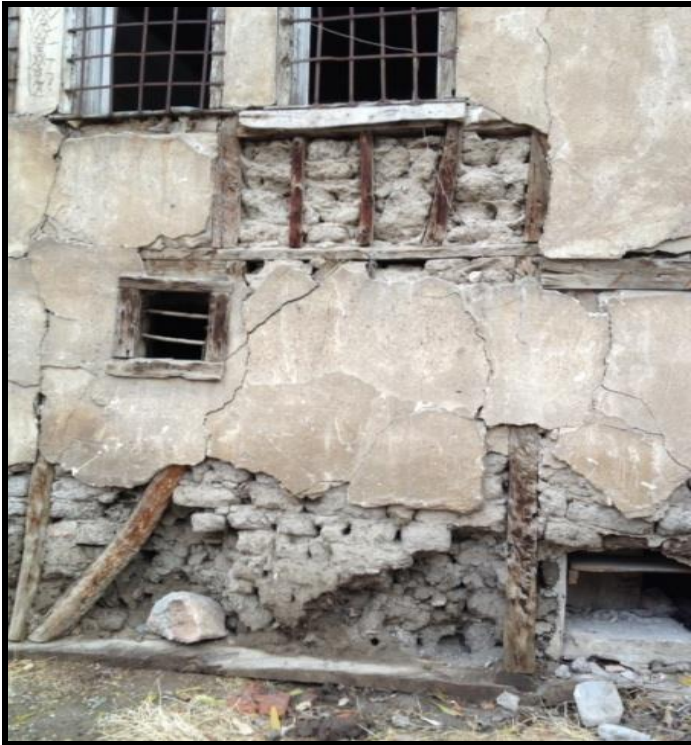
Resim 4.117. Sol cephe duvarı, yapım sistemi
