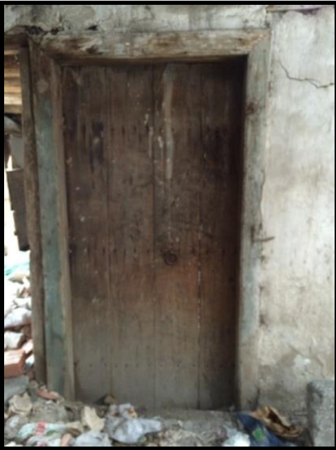
Resim 4.136. K2 ahır kapısı
