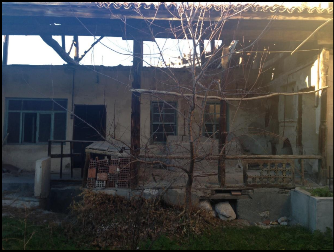
Resim 5.44. 5 nolu konak cephesi
