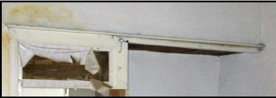
Resim 4.186. 102 nolu oda gusülhane ve yüklük üzerindeki ahşap sergen
