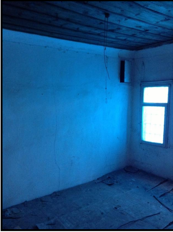
Resim 4.72. 102 mekan dv1 duvarı
