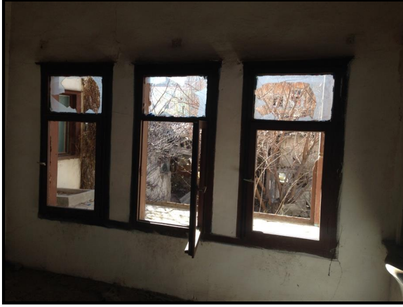
Resim 4.84. 104 mekan DV4 duvarı
