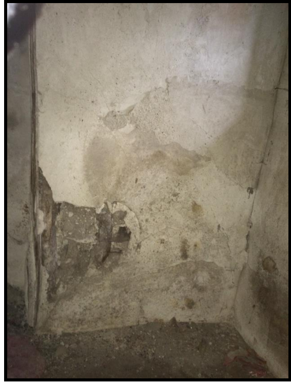
Resim 4.13. Z02 mekanı dv3 duvarı
