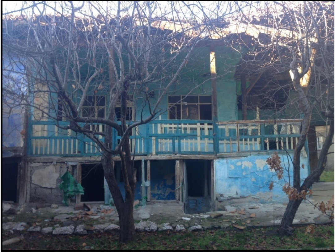
Resim 5.46. 7 nolu konak cephesi
