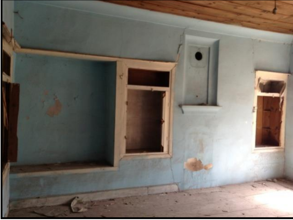
Resim 4.102. 108 mekan dv2 duvarı
