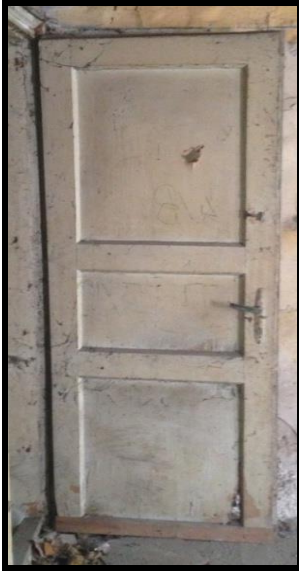
Resim 4.149. K.Z10.1 nolu kapı
