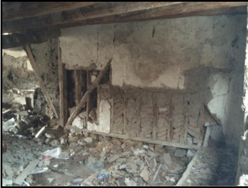
Resim 4.123. Ahır dv2 duvarı
