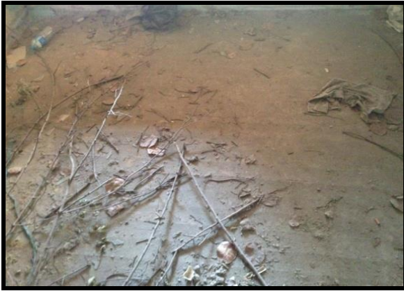
Resim 4.27 Z04 mekan döşemesi
