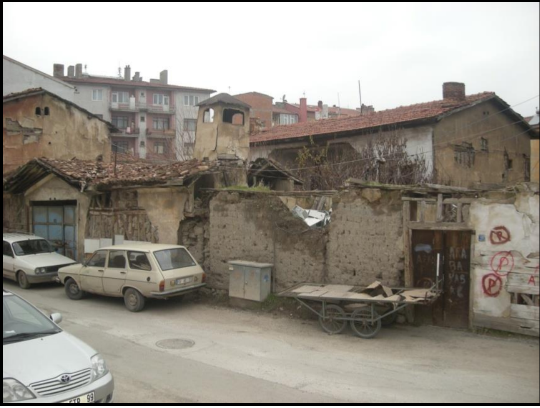
Resim 3.3. Satıcı konağı ve hakkı bilal konağı avlu girişi, osmancık 4.sokak
