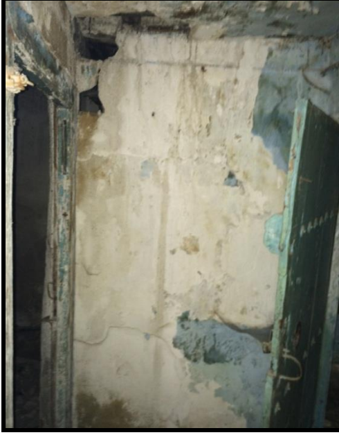
Resim 4.20. Z03 hol DV2 duvarı
