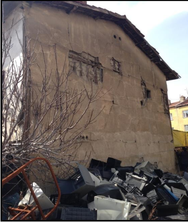
Resim 4.4. Satıcı konağı doğu cephesi
