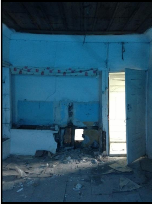
Resim 4.75. 102 mekan dv4 duvarı
