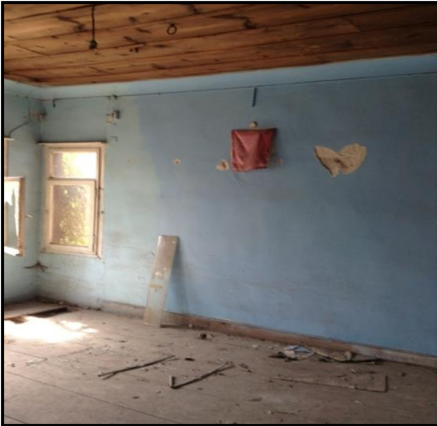
Resim 4.104. 108 mekan dv4 duvarı
