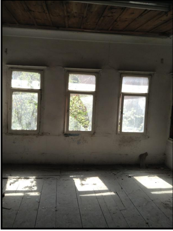
Resim 4.68. 101 mekan dv2 duvarı
