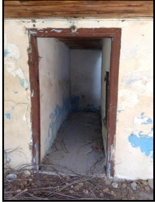
Resim 4.30. Z05 hol dv2 duvarı
