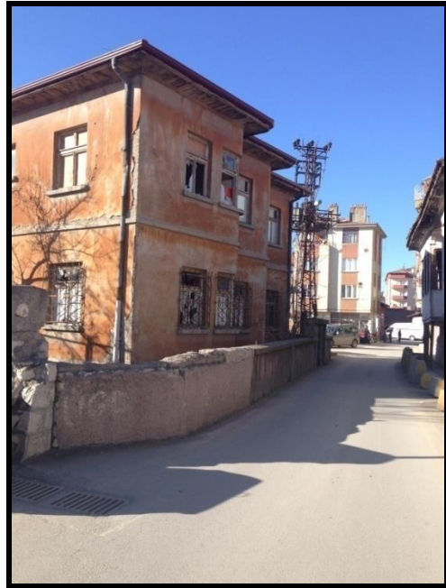
Resim 3.5. Satıcı Konağı batısı
