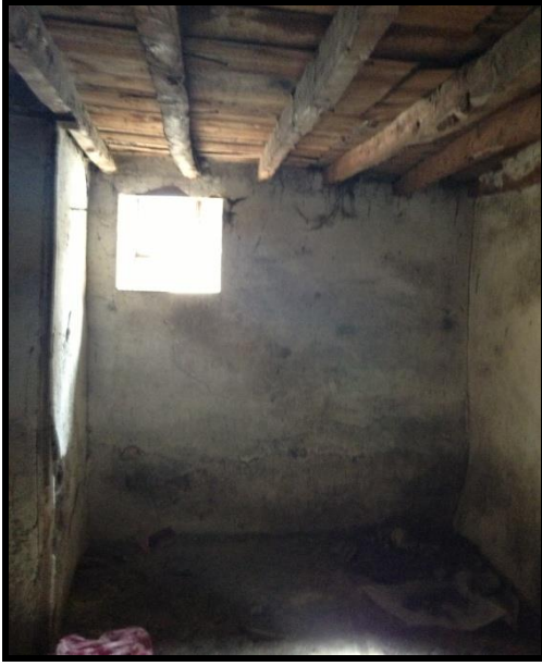
Resim 4.14. Z02 mekanı dv4 duvarı
