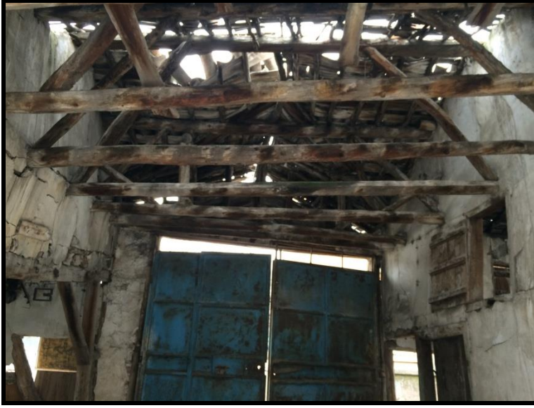
Resim 4.132. Avlu giriş saçağı kiriş sistemi
