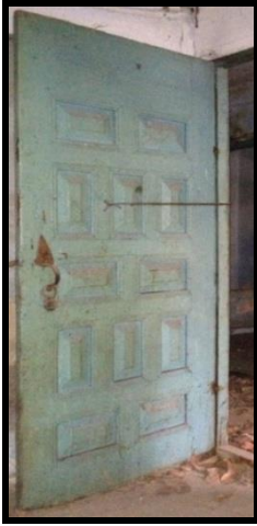
Resim 4.151. K.Z01.1 nolu kapı
