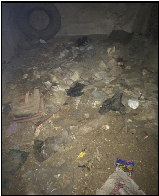
Resim 4.38. Z06 mekan toprak döşemesi
