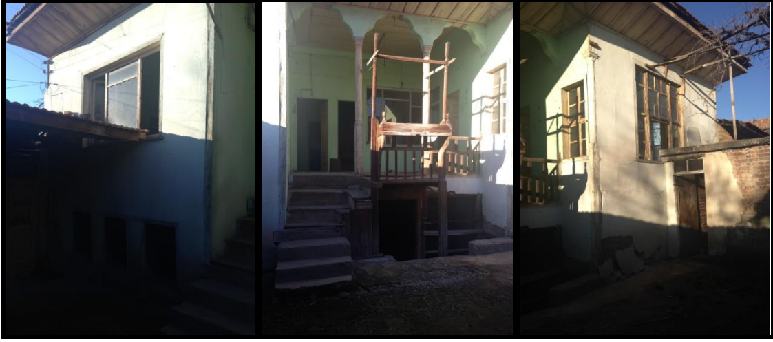
Resim 5.45. 6 nolu konak cephesi
