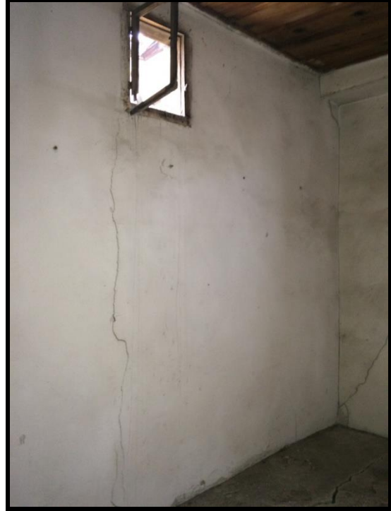
Resim 4.92. 106 mekan dv2 duvarı
