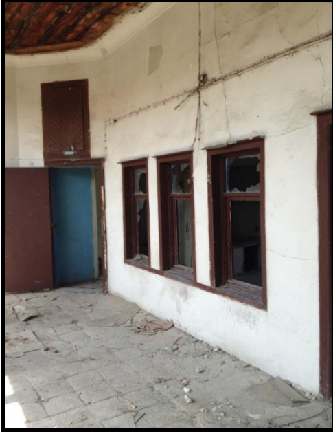
Resim 4.209. Kırılma, 104 pencereleri
