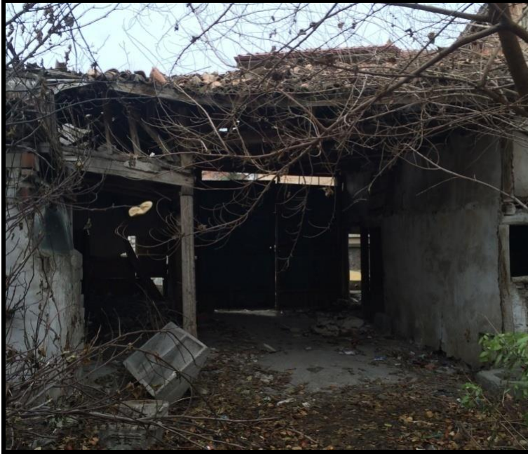
Resim 4.133. Avlu giriş saçağı, çatısı
