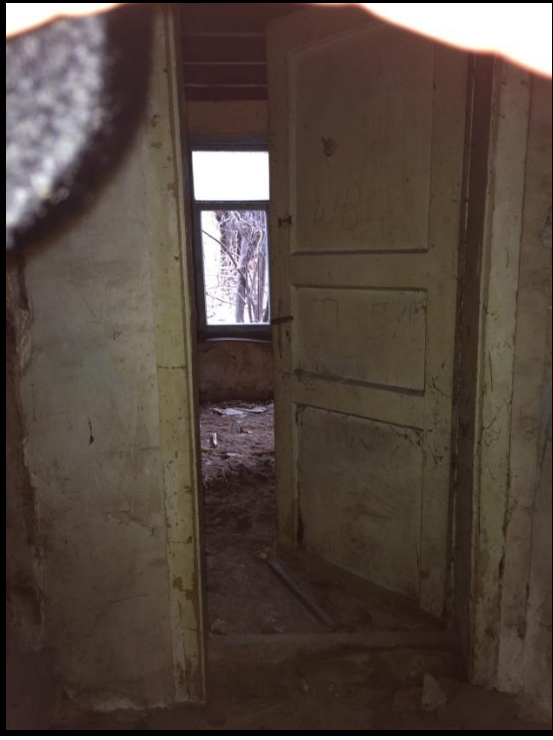
Resim 4.45. Z08 hol dv3 duvarı
