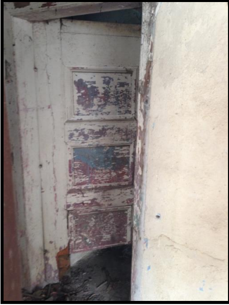
Resim 4.148. K.Z08.1 nolu kapı
