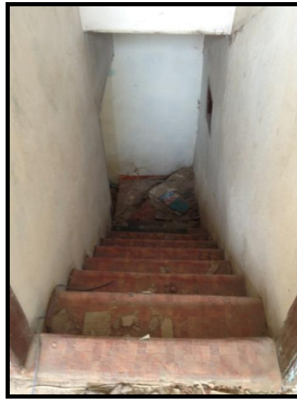
Resim 4.88. 105 hol dv2 duvarı
