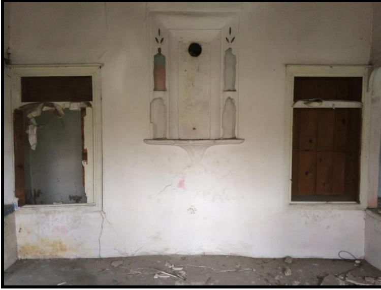
Resim 4.82. 104 mekan dv2 duvarı
