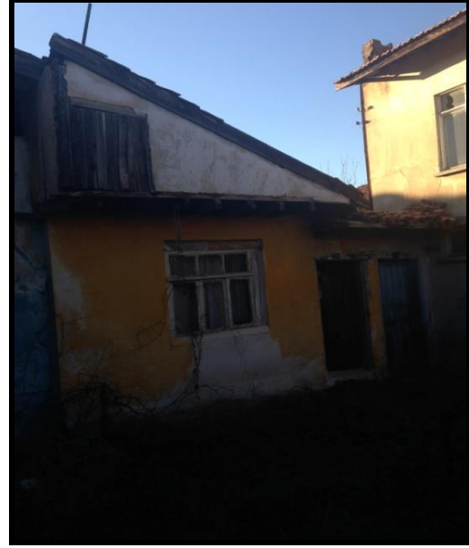
Resim 5.4. 5 nolu konak müştemilatı cephesi
