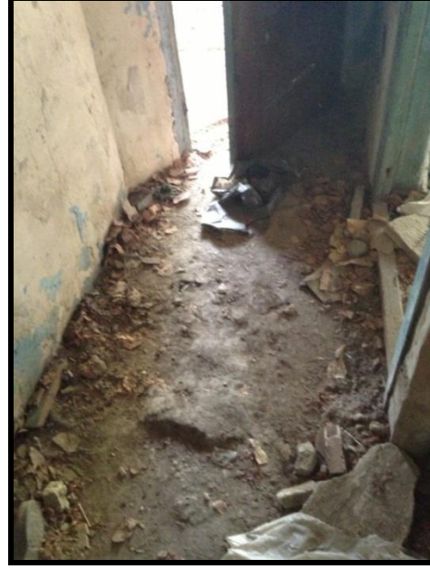
Resim 4.21. Z03 hol döşemesi
