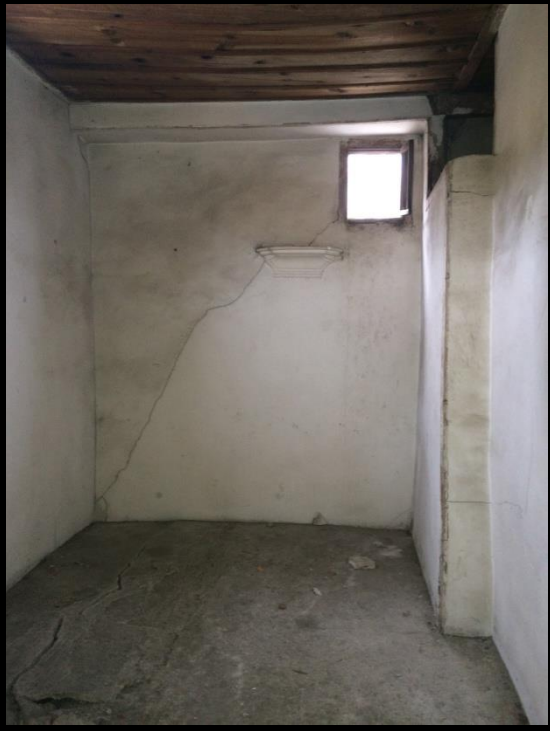
Resim 4.93. 106 mekan dv3 duvarı
