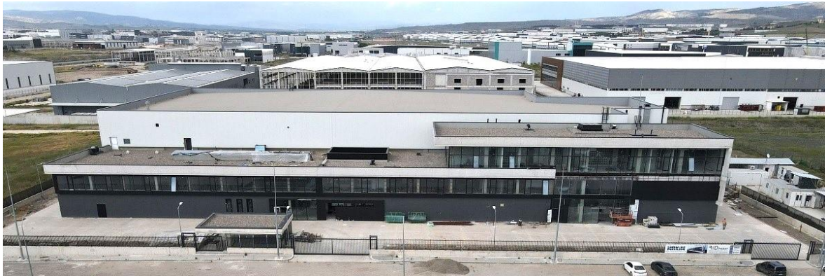
Resim 3.4. Makim Yeni Üretim Tesisi / ön cephe (URL-145)
