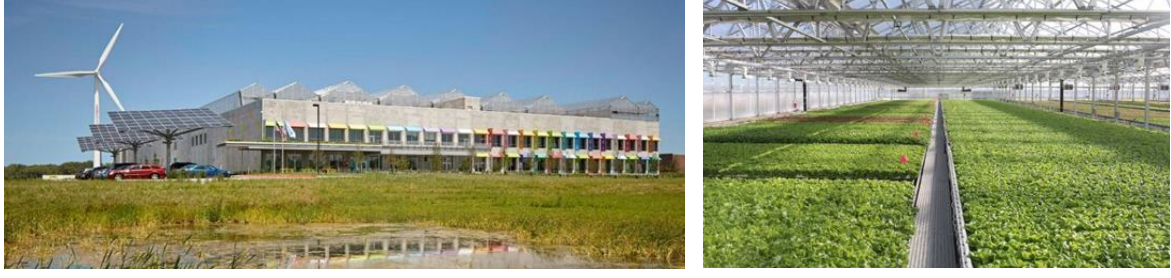
Resim 2.3. Method Fabrikası ve arazi ilişkisi, rüzgar türbini ve güneş ağacı kanopiler (sol) ve çatı serası (sağ) (URL-59)
