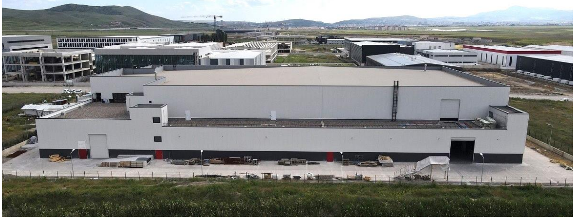
Resim 3.5. Makim Yeni Üretim Tesisi / arka cephe (URL-145)
