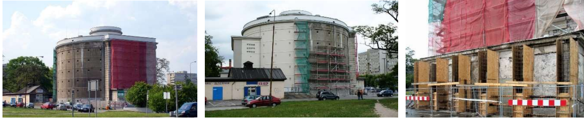
Resim 4.8. MWW inşaat süreci (URL-28)
