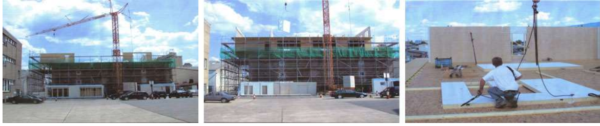
Resim 4.2. KulturBunker inşaat süreci (URL-24)
