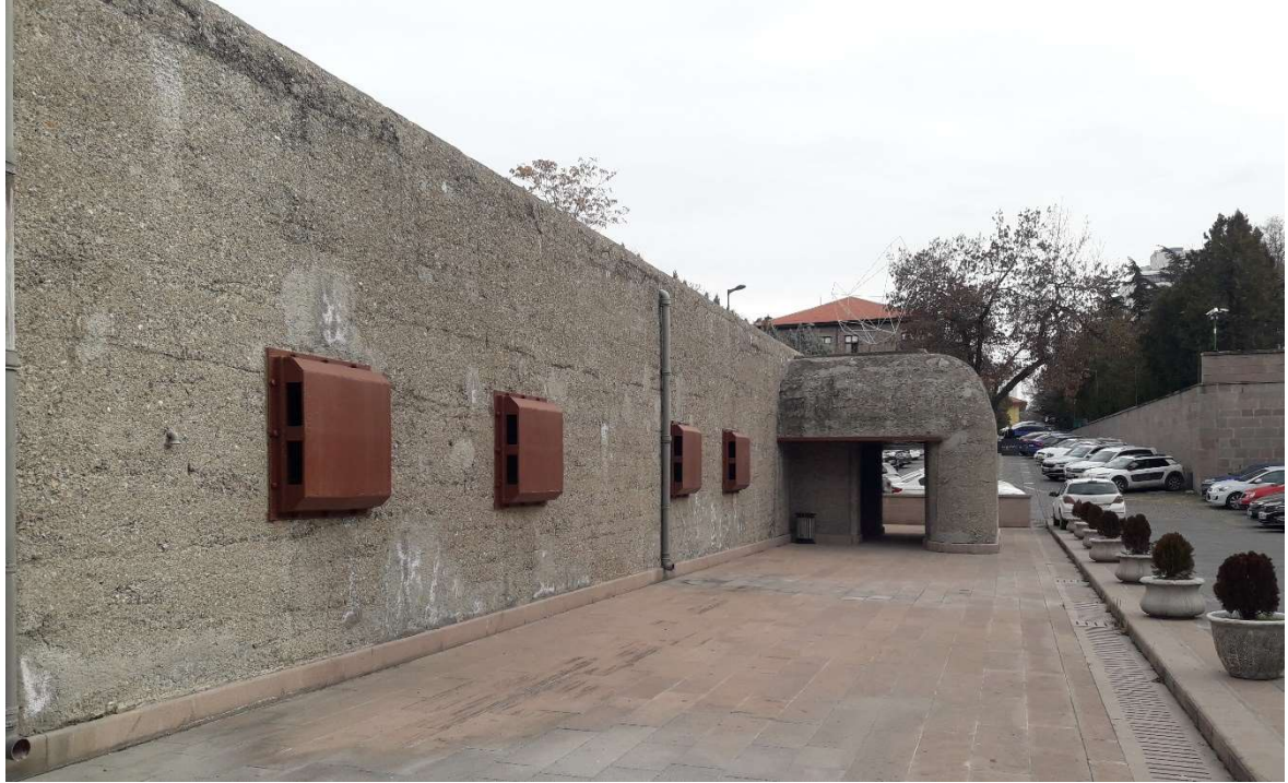
Resim 4. II. Meclis Binası Sığınağı ön cephesi (Alihan Barış Fotoğraf Arşivi, 2024)
