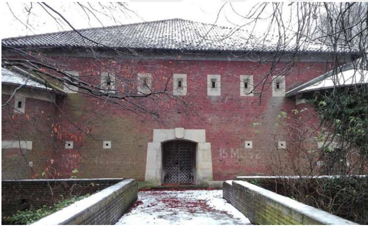
Resim 3.9. Lazarettstraße Bunker, Münster (Calandra di Roccolino, 2021)
