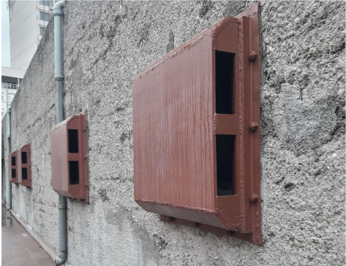
Resim 2. II. Meclis Binası Sığınağı havalandırma açıklıkları (Alihan Barış Fotoğraf Arşivi, 2024)
