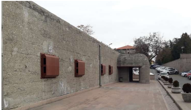
Resim 4.15. II. Meclis Binası Sığınağı - yeniden işlevlendirme sonrası (Alihan Barış Fotoğraf Arşivi, 2024)
