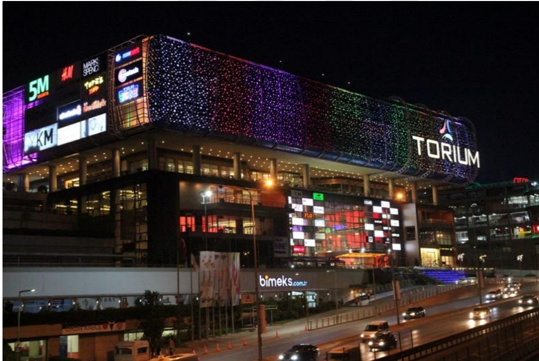
Resim 4.1. Torium alışveriş merkezinin dış cephe görünüşü [38]
