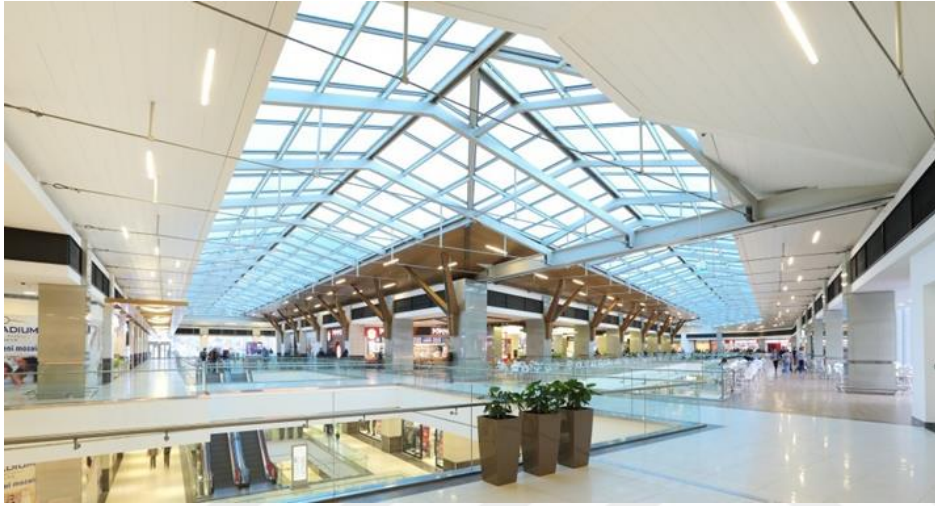
Resim 4.14. Palladium avm iç mekandaki ışıklık ve havalandırma detayları [43]
